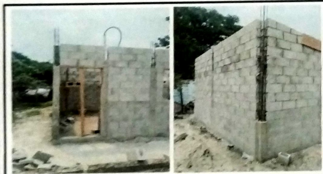
Foto 3: MODULO COCINA Levantado de block y cubierta de lamina troquelada cal 26 + estructura de metal a base de costaneras.
