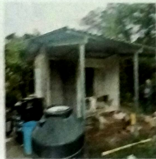
Foto 8: MODULO DE SERVICIO SANITARIO. Vista Frontal proceso de desmontaje de cubierta de lamina de zinc, vista de instalacion de cubierta de lamina troquelada cal 26 y estructura de metal.
