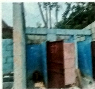
Foto 9: MODULO DE SERVICIO SANITARIO. Vista Frontal proceso de desmontaje de cubierta de lamina de zinc, vista de instalacion de cubierta de lamina troquelada cal 26 y estructura de metal. Aplicación de acabados en muros.
