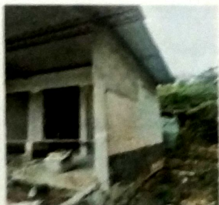
Foto 11: MODULO DE SERVICIO SANITARIO. desmontaje de cubierta de lamina de zinc, vista de cubierta de lamina troquelada cal 26 y estructura de metal. Aplicación de acabados en muros.
