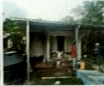
Foto 10: MODULO DE SERVICIO SANITARIO. Vista Frontal proceso de desmontaje de cubierta de lamina de zinc, vista de instalacion de cubierta de lamina troquelada cal 26 y estructura de metal. Aplicación de acabados en muros.
