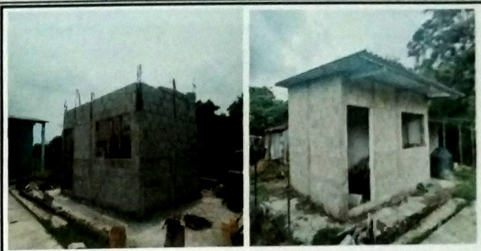
Foto 2: MODULO COCINA Levantado de block y cubierta de lamina troquelada cal 26 + estructura de metal a base de costaneras.
