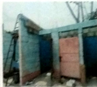
Foto 10: MODULO DE SERVICIO SANITARIO. Vista Frontal proceso de desmontaje de cubierta de lamina de zinc, vista de instalacion de cubierta de lamina troquelada cal 26 y estructura de metal. Aplicación de acabados en muros.
