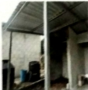
Foto 9: MODULO DE SERVICIO SANITARIO. Vista Frontal proceso de desmontaje de cubierta de lamina de zinc, vista de instalacion de cubierta de lamina troquelada cal 26 y estructura de metal. Aplicación de acabados en muros.
