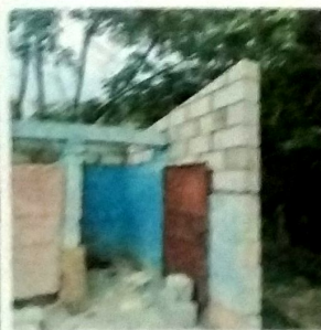
Foto 11: MODULO DE SERVICIO SANITARIO. desmontaje de cubierta de lamina de zinc, vista de cubierta de lamina troquelada cal 26 y estructura de metal. Aplicación de acabados en muros.
